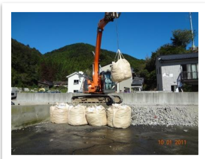
かさ上げ作業中
